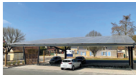
Exemple d'ombrières de parking. Crédit See You Sun
